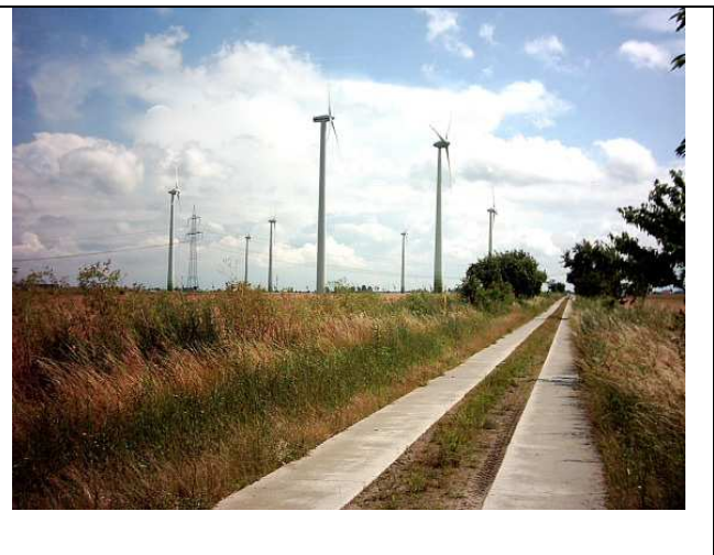
Windpark Zörbig – Beton
