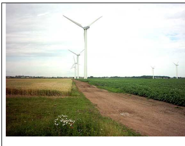
Windpark Wörbzig – Schotter
