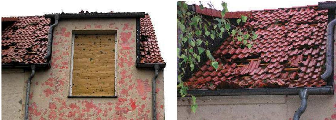
Abbildung 2.30: Hagelschäden an Gebäuden
