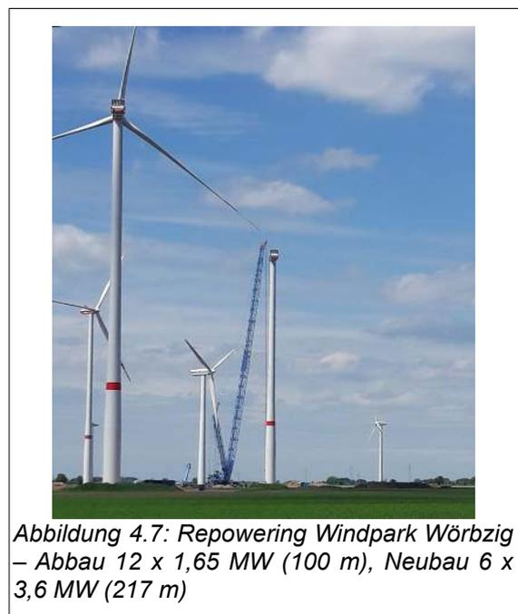
Abbildung 4.7: Repowering Windpark Wörbzig – Abbau 12 x 1,65 MW (100 m), Neubau 6 x 3,6 MW (217 m)
