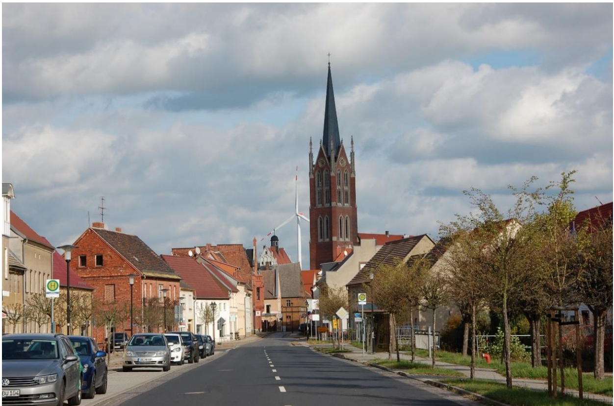
Abbildung 60: Beeinträchtigung des Marktplatzes von Kemberg durch eine WEA, die Gesamthöhe der WEA zur Höhe der Bebauung beträgt 1:1 bis 1,5, Die WEA wirkt dominant in den Stadtraum hinein (Foto: K. Reichhoff, 25.10.2019)
