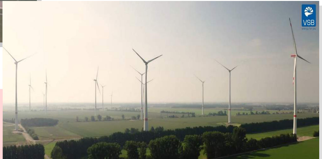
Windpark Elster 2025 nach Repowering (Foto VSB Gruppe) 16 x 6,6 MW, 242,5 m Gesamthöhe
