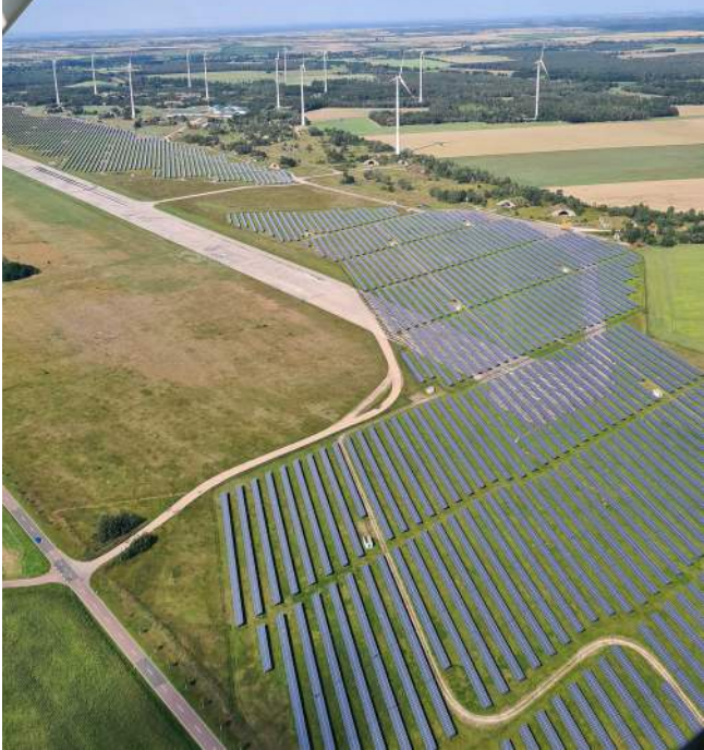
Solaranlage auf ehemaligem Militärflugplatz Zerbst
